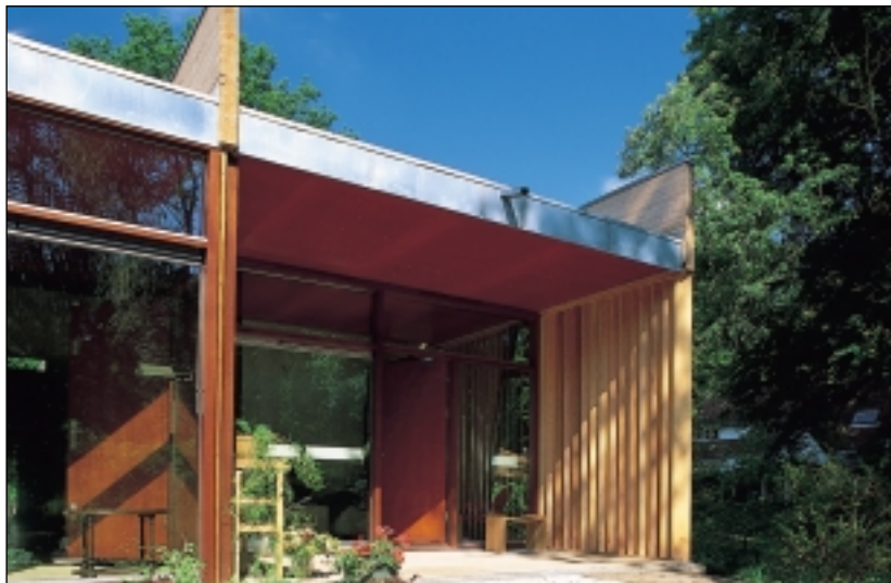
◁ De diverse houttoepassingen verlevendigen het minimalisme.
